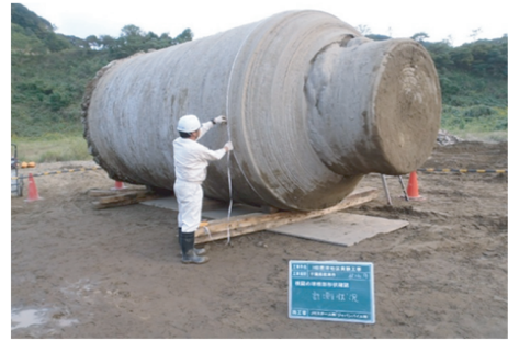
写真3 掘り出し後の根固め球根姿図
